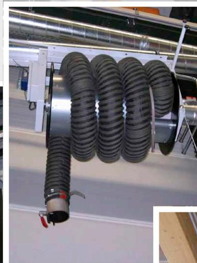
Links: Elektrischer Aufroller mit zentralem Ventilator.
